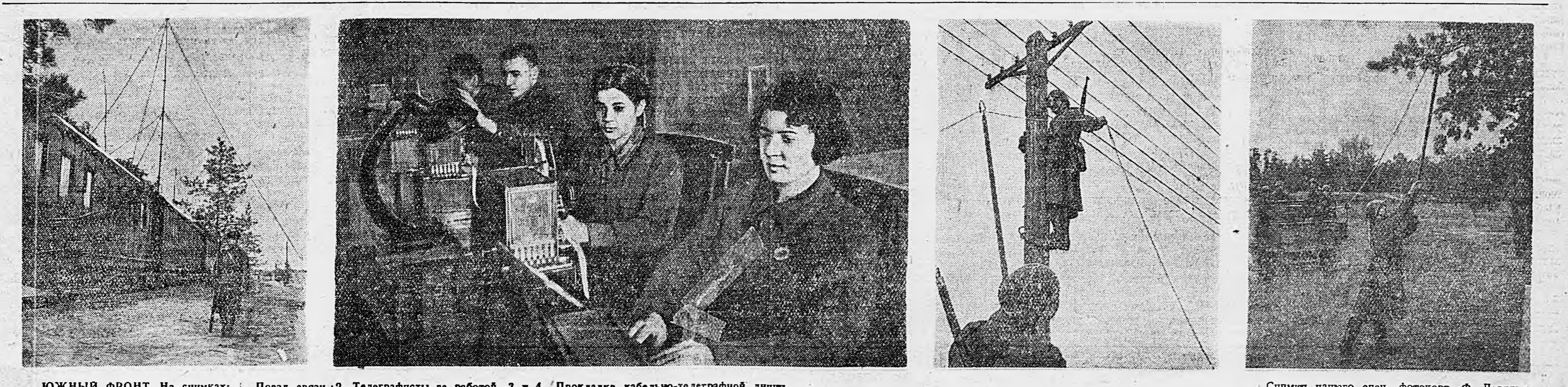
ЮЖНЫЙ ФРОНТ. На снимках: 1. Поезд связи. 2. Телеграфисты за работой. 3 и 4. Прокладка кабельно-телеграфной линии. Снимки нашего спец. фотокорр. Ф. Лештля.
