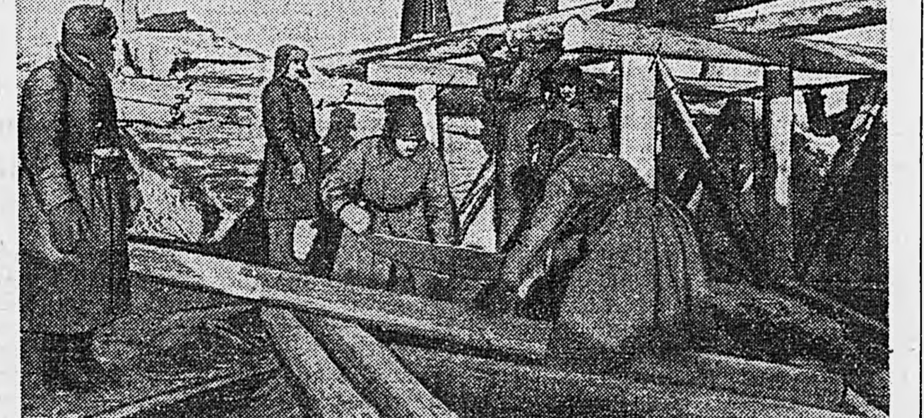
Западный фронт. На снимке: саперы подразделения старшего лейтенанта А. Фокина восстанавливают разрушенный мост на участке, отбитом у немцев. Снимок специального фотокорреспондента «Красной звезды» О. Кнорринга.
