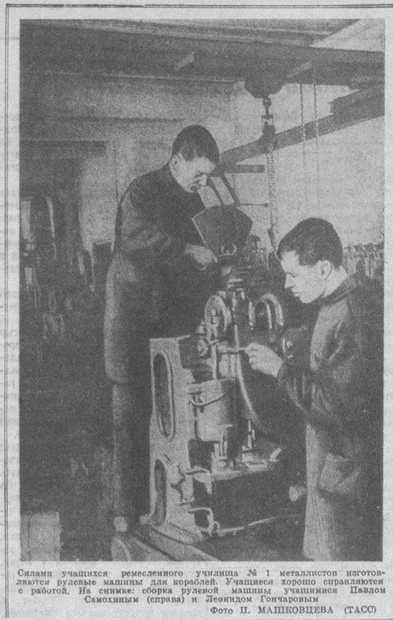
Силами учащихся ремесленного училища № 1 металлисты изготовляют рулевые машины для кораблей. Учащиеся хорошо разбираются в работе. На снимке: сборка рулевой машины учащимися Павлом Самохиным (справа) и Леонидом Голызовым. Фото П. МАЛПОВИЧЕВА (ТАСС)
