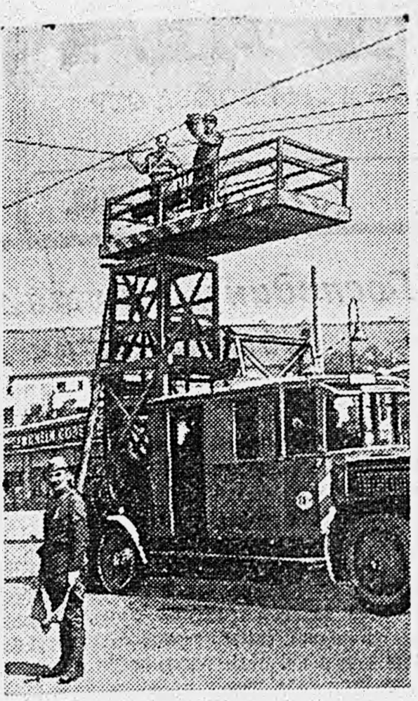
В БЕРЛИНЕ. Ремонт трамвайной электротрибы. Снимок нашего спец. фотокорр. О. Кюрринга.
